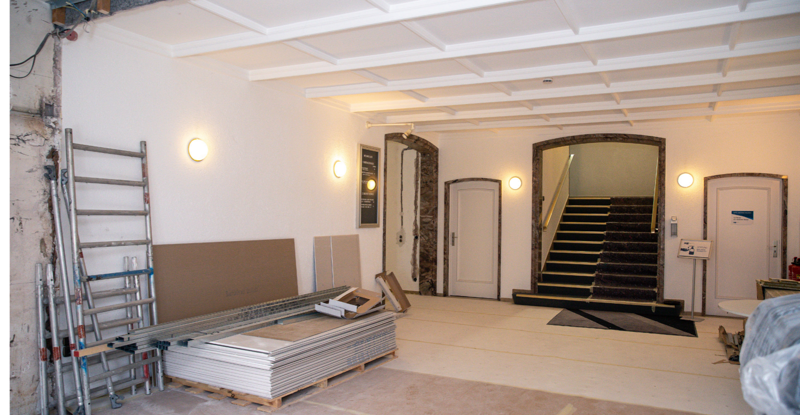
Im Dezember 2020 begannen Instandhaltungsmaßnahmen der Niederlassung Sonneberg.
